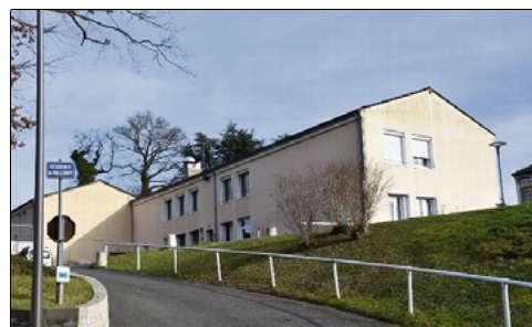
Le site est fermé et sécurisé en attendant sa démolition.
